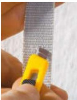
Schneiden Sie den Gurt ein (etwa 20 mm hinter dem Gurtende). Gelochten Gurt an der Lasche der Gurttrommel des Aufschraubwicklers einhängen.
